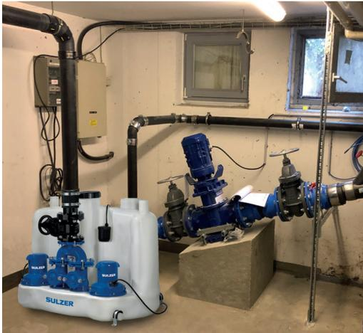
Das Foto zeigt einen Doppelwellenzerkleinerer Muffin Monster Kanalausführung in einer Abwasserpumpstation direkt im Zulaufbereich. Hier muss das Abwasser durchströmen und bei Anstau von zu vielen Feststoffen werden diese problemlos zerkleinert, bevor sie die Pumpe erreichen.
